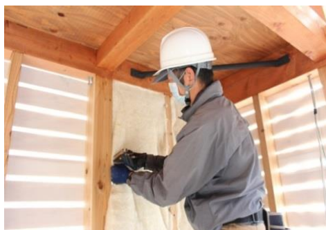
⑦ 片側ずつ150~200mm間隔で留めていきます。
