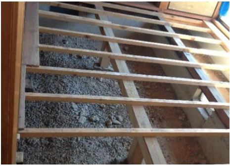
① 土台・大引の上面に床根太を施工します。
