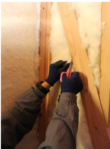
④ 筋交いに添って切り込みを入れます。(50mm程度)
