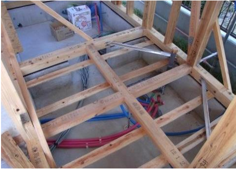
① 土台・大引の間にバラ板等の受材を施工します。
