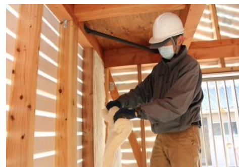
③ ウールプレスの上端を折り曲げます。
