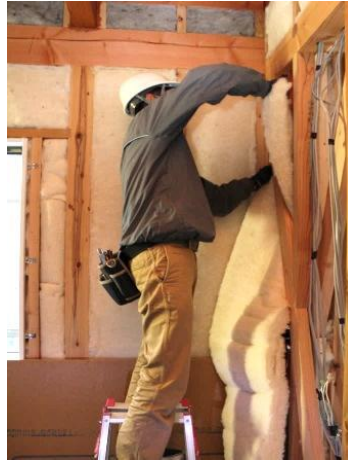
② 筋交いの裏にウールプレスを入れ込んで充填します。
