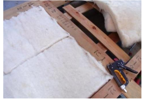
③ ウールプレスを敷き込んで施工完了です。
