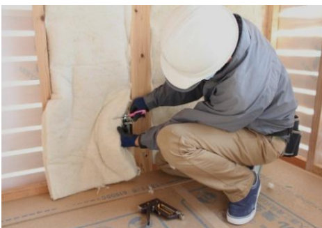
① コンセントボックスの高さに添って切り込みを入れます。
