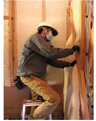
③ 両サイドをタッカーで固定します。
