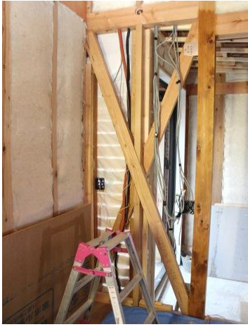
① 壁の高さを採寸し、ウールプレスを寸法に合わせてカットします。
